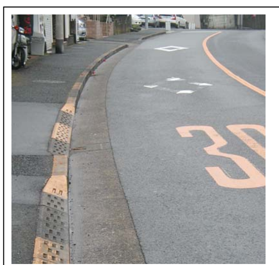
(図10) 自転車は舗装の継ぎ目に沿って走行することを強いられる。道路設置者には配慮の外？
