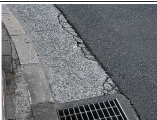
（図11）側溝蓋や舗装の割れ目が自転車のタイヤをとらえる
